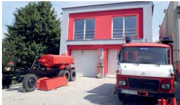
Práce na zovňajšku budovy sú už hotové, ostáva dokončiť interiér. (foto: P. Hrehušová)
