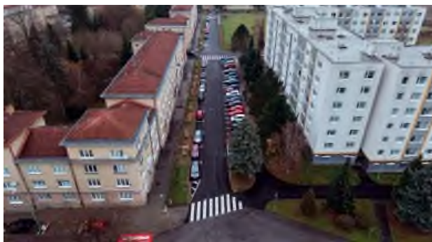
Kompletná oprava povrchu na Ulici Janka Kráľa.
