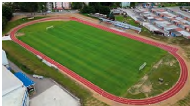
Úspešne dokončený projekt tartanovej dráhy.
