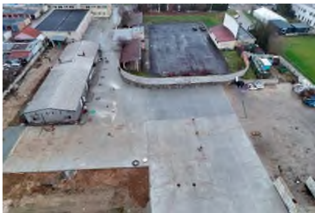
Oprava viac ako 80% spevnených plôch na zbernom dvore.
