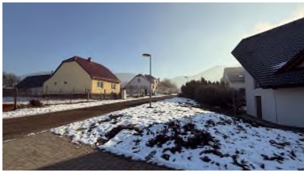
Obyvatelia lokality pod Húštikom na Farskej ulici sa dočkajú nového vodovodného potrubia s výtlačnou stanicou.
