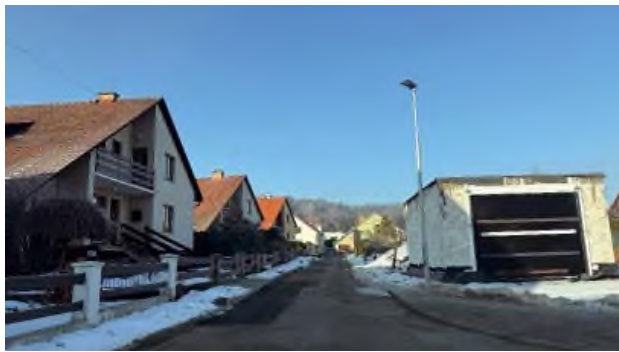
Ulica J. G. Tajovského - po rekonštrukcii plynovodu je naplánovaná obnova asfaltových povrchov.
