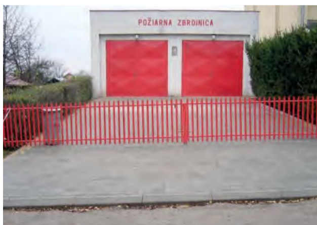
Požiarňa zbrojnica v Kolačine pred rekonštrukciou. Po ukončení bude ponúkať viac možností pre členov. Foto: DHZ.
