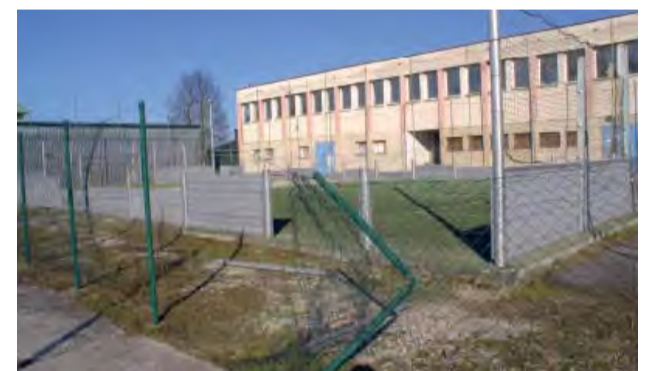
Ihrisko za domom športu je v súčasnom stave pre deti nebezpečné. (foto: P. Hrehušová)
